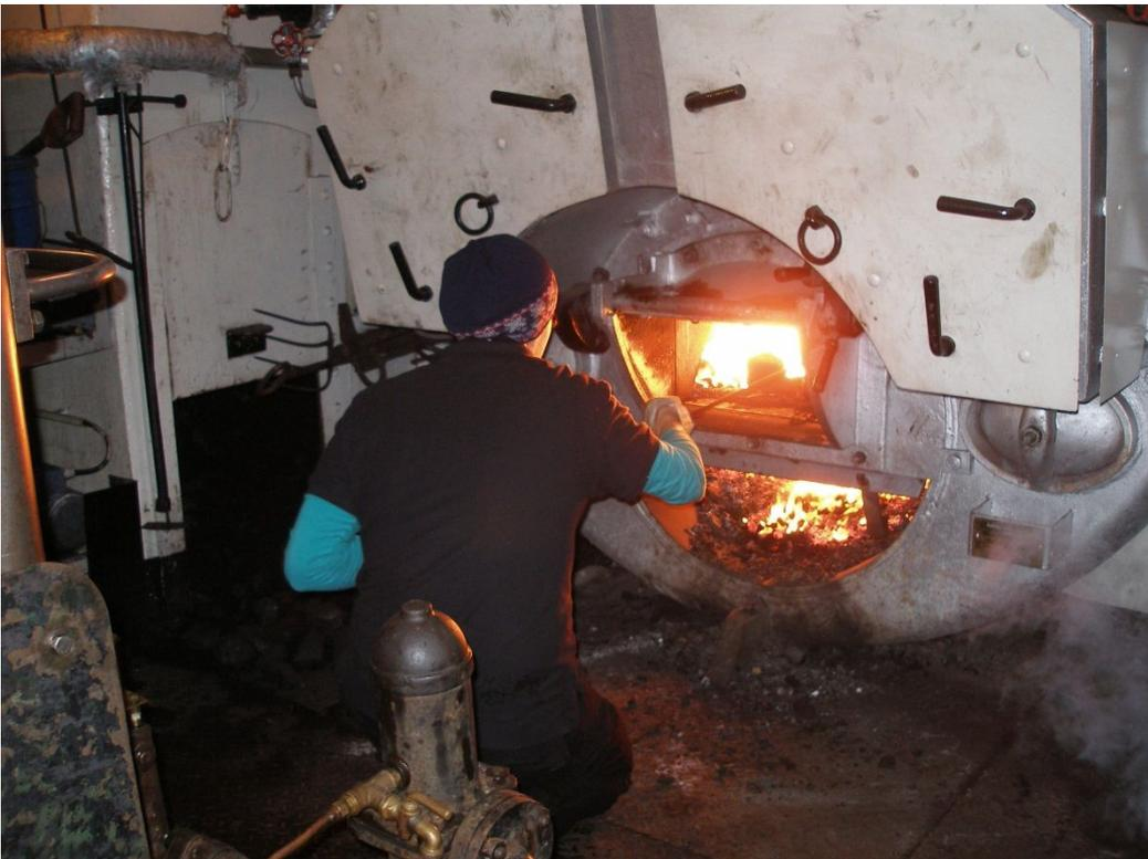
So ein Dampfkessel ist ein wenig menschlich - was oben hineinkommt, muss in Teilen auch unten wieder heraus. Ein gewisser Ascheanteil fällt immer an und es muss die Asche aus dem Flammrohr, bzw. dem Aschfall entfernt werden. Das nennt man dann "Ascheziehen". Eine durchaus warme und auch staubige Geschichte.
