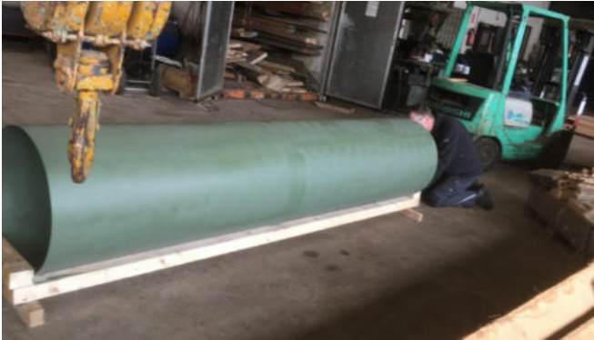
Das neue Rohr ist da und wird konserviert.
