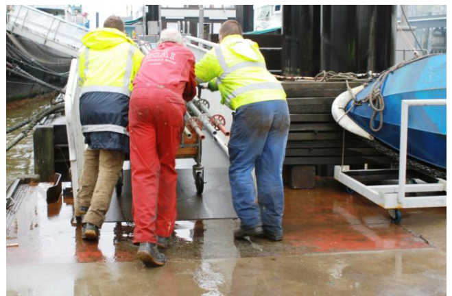
Die Jungs vom Schwimmkran erledigten ihren Job in bestem Teamwork.
