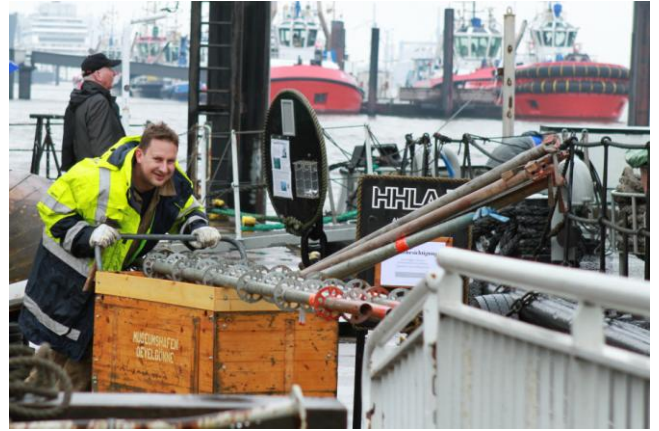
Auch Vorbereitungen für die Hapag-Lloyd-Azubi-Woche konnten schon getroffen werden...(Einrüsten des Handkrans für einen neuen Anstrich)
